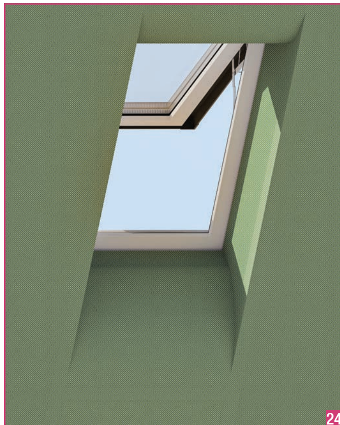
Закреть утеплитель пароизоляционной мембраной.
