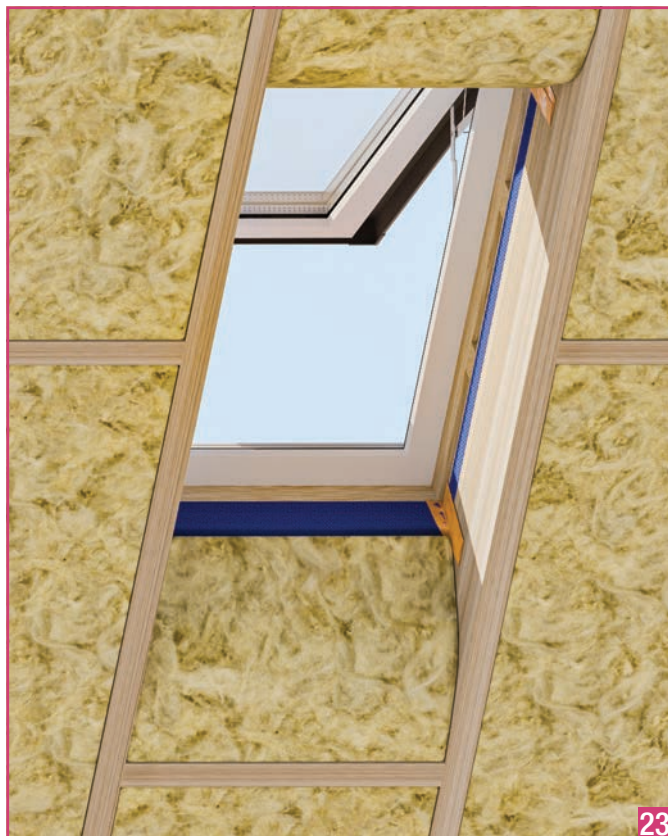
Разместить утеплитель в стропильную систему.
